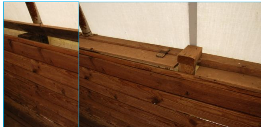
Ventilação lateral ( aberta e fechada)
