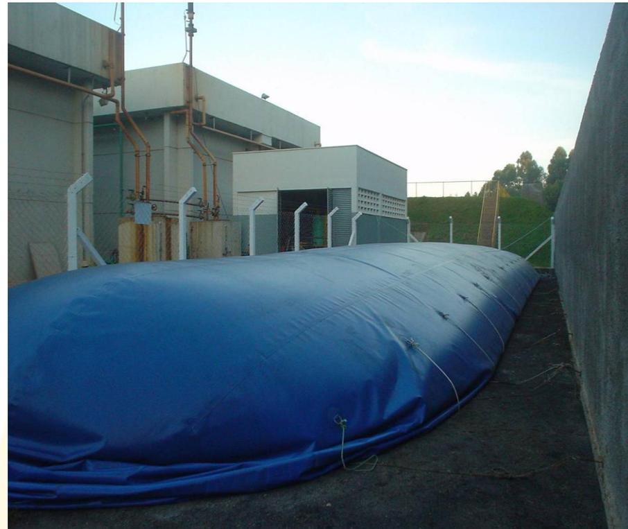
Balão de PVC para o armazenamento do biogás a baixa pressão
